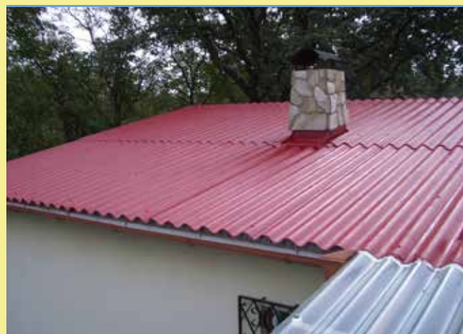
Wellplattensanieurung mit Beschichtung
