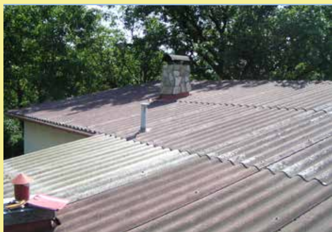
Wellplattensanieurung mit Beschichtung
