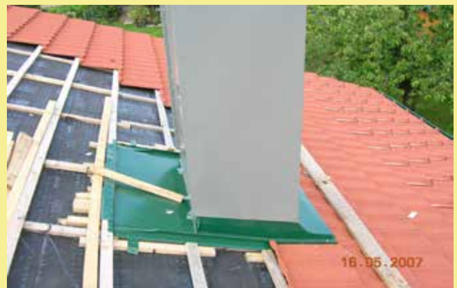
Wellplattensanierung mit sturmfesten Stahlprofilen in Ziegeldesign
