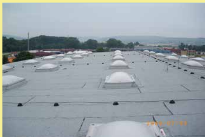
Kiesdachsanieurung mit Elastomerbahnen
