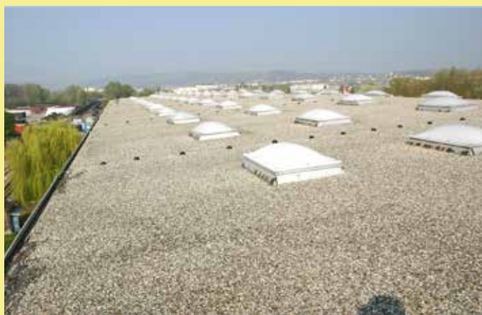
Kiesdachsanieurung mit Elastomerbahnen
