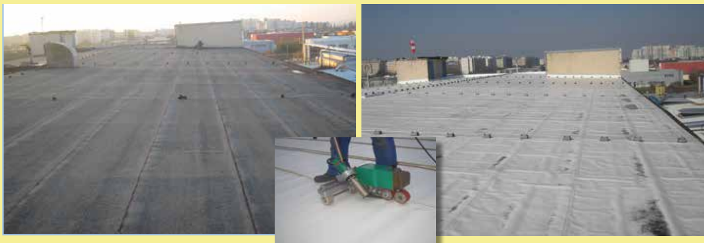
Flachdachsanieung mit Folie
